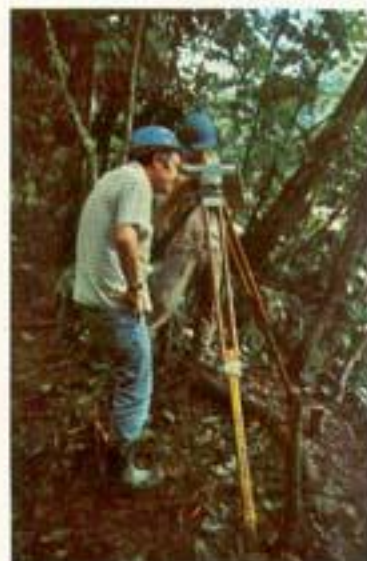
Topógrafos en plena labor durante los trabajos iniciales de superficie en un área bajo exploración.
