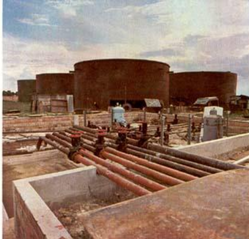
En la Planta de Ventas de Iquitos están siendo construidos 6 nuevos tanques de almacenamiento de combustibles, con una capacidad de 83 mil barriles, para cubrir las necesidades del consumo regional.
