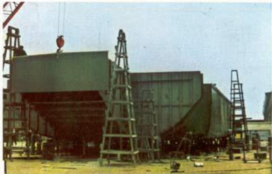
En los astilleros de Febrimet se construyen en el Callao las embarcaciones fluviales que empujarán las barcazas que transportarán petróleo por los ríos de nuestra Selva.
