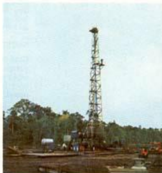
Secuencia de la erección de una torre armada en el lugar donde se realizó la perforación del nuevo pozo. Trompeteros X-11.
